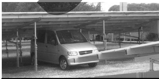
自動車。高さが十分ない。移動に よるモジュール破損や燃料の引火 が考えられる。注意喚起する。
