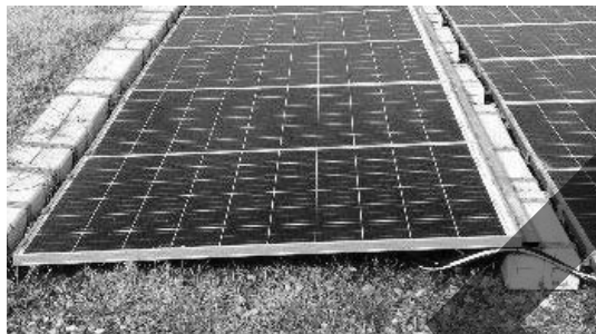
枯れ草。パネルと隙間が小さいため枯れ草に引火しやすい。
