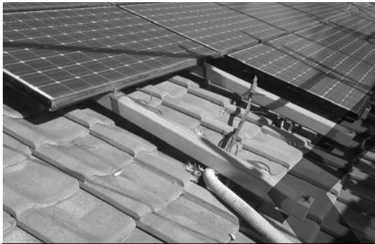
配管交換のため1枚撤去
