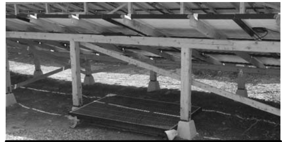
予備太陽電池。雨ざらしで予備と しての役目が果たせるのか疑問。 濡れた状態の漏電が心配である。
