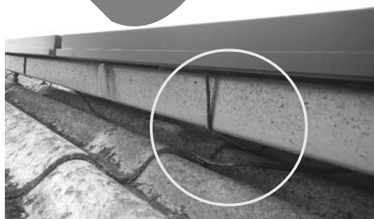
結束材破損により配線が垂れる
