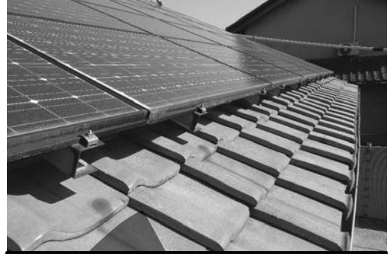
屋根との隙間は10~15cm
