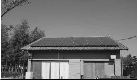
アレイと竹林との離隔は約10m 離れていても風で運ばれる
