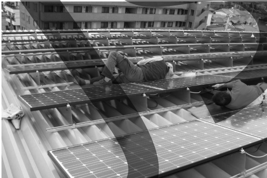
屋根置き傾斜設置型(折半屋根)
