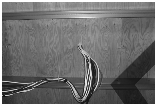
天井内、保護管なし、貫通部分
