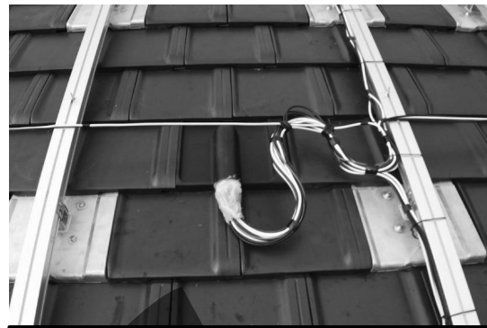
屋根上、平板瓦用配線瓦
