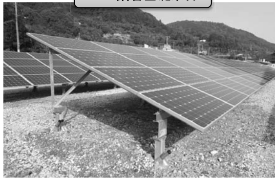
FXT鋼管基礎架台
