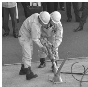
鋼管斜打ち基礎 (FXT基礎) 架台方式
