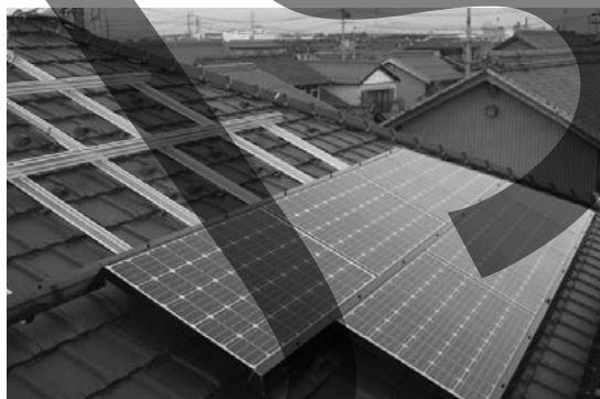
屋根置き設置型(瓦、傾斜屋根)
