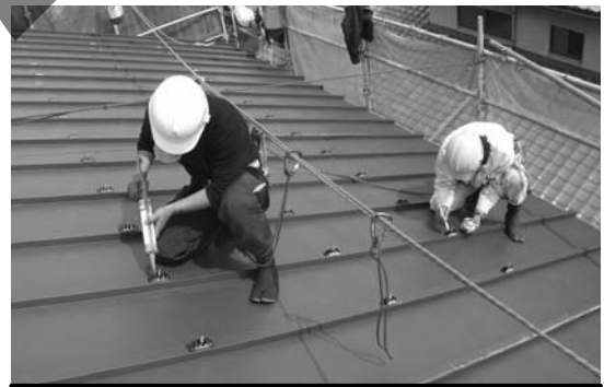
1日目、屋根直接設置型防水処理
