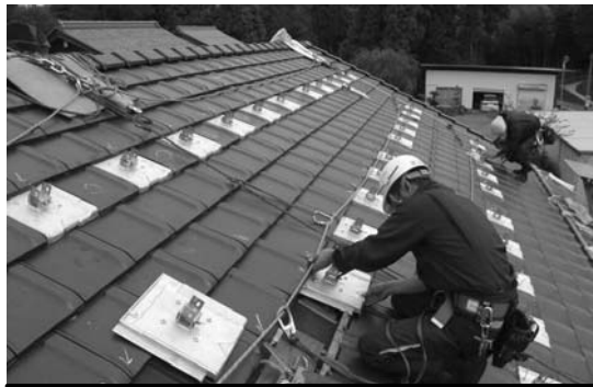
⑤取り付け金具、屋根材取り付け
