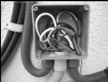
直流にもかかわらず単芯線を使っていない PVResQ!: PV - Reliable, Safe and Sustainable Quality!
