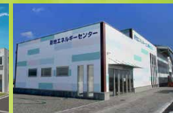
新地エネルギーセンター
