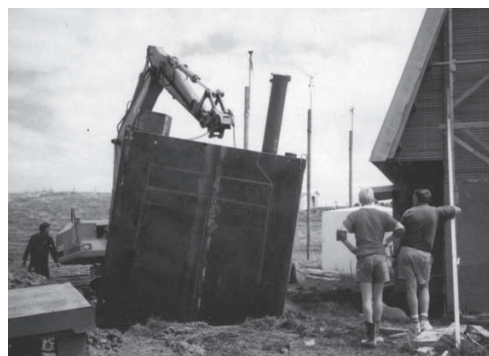
図9 尾関式浄化槽
