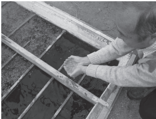
図10 温室での雑排水の浄化(放流口は手前隅)
